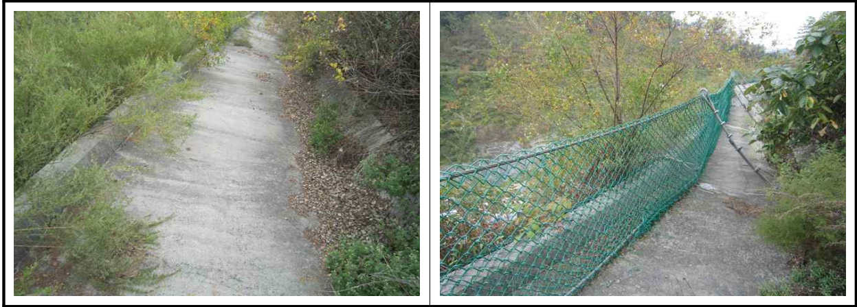
【그림 3.3.3】 배수시설 전경
